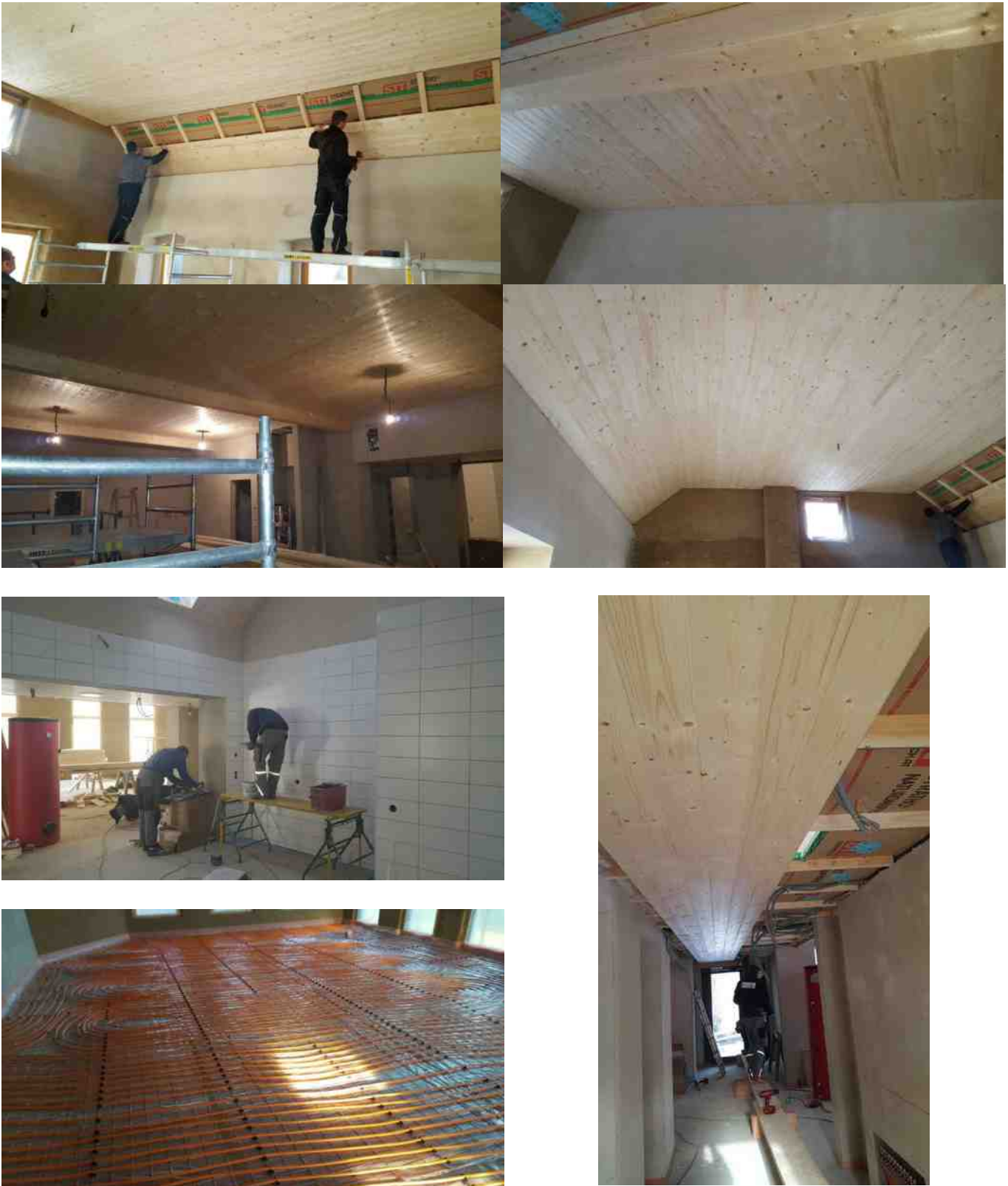
Fotos von der KuK-Haus Baustelle
